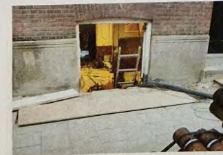
Kelder verdiepen en waterdicht maken. (foto Defacto)
